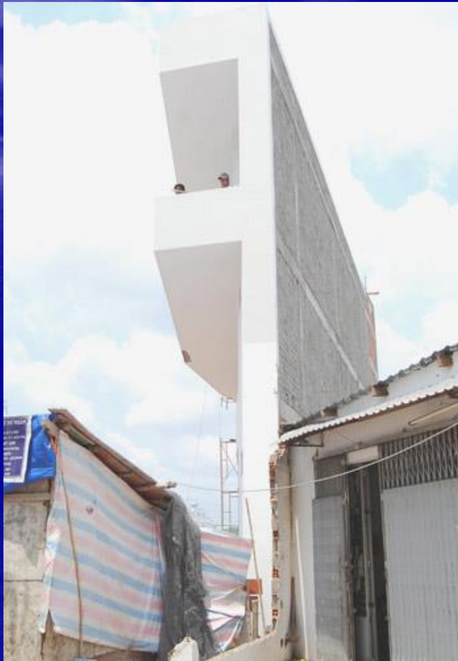
NHÀ SIÊU MỎNG TẠI HÀ NỘI (ĐANG THI CÔNG)
