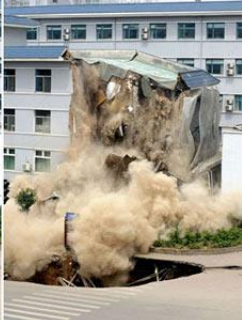
GIAI ĐOẠN 2 – SỤP TOÀN BỘ, DO NƯỚC NGẦM (TRUNG QUỐC) 2010
