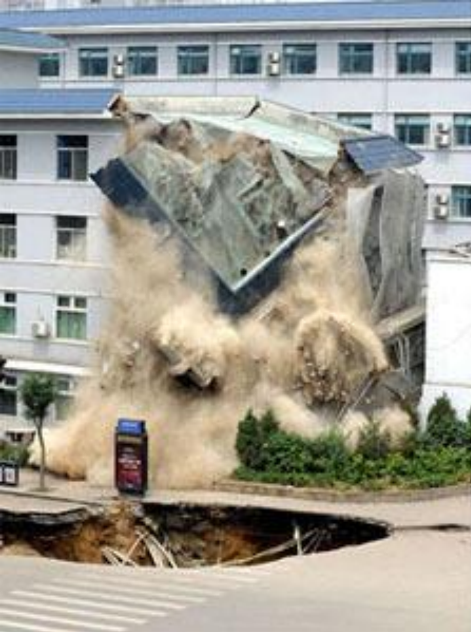
GIAI ĐOẠN 2 – SỤP TOÀN BỘ, DO NƯỚC NGẦM (TRUNG QUỐC) 2010
